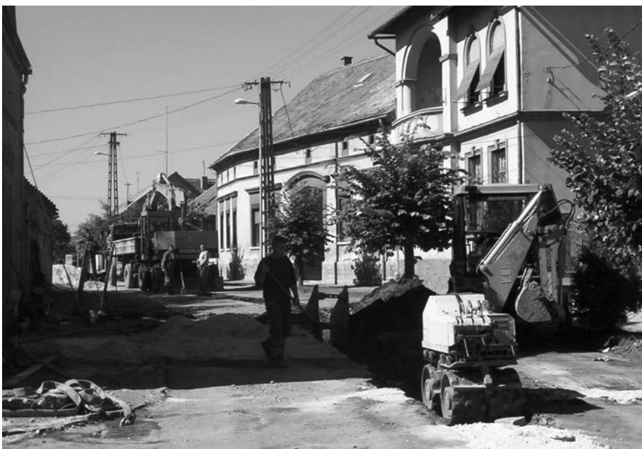
Devecserben a csatornaépítéssel párhuzamosan vízvezeték rekonstrukcióra is sor került
