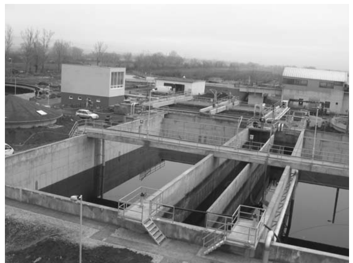
Decemberben kezdi a próbaüzemet a Veszprémi Szennyvíztisztító telep III/3. üteme
