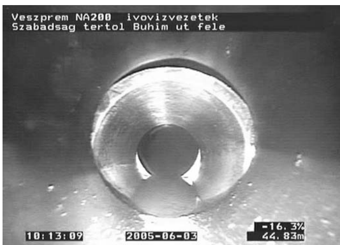
A csővezeték bélelés előtti állapota
