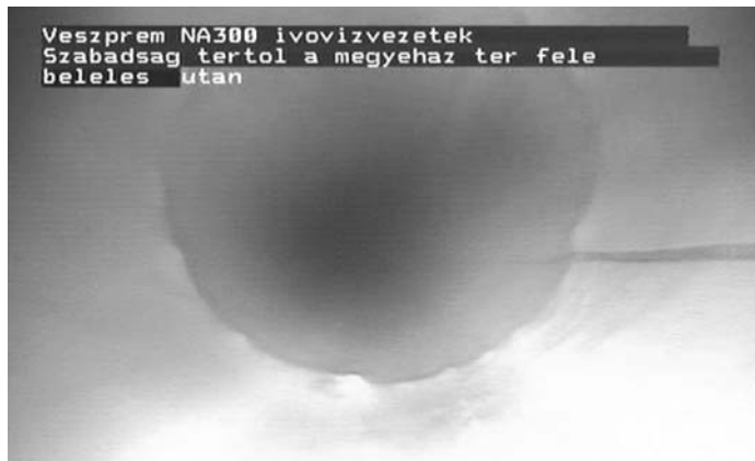
A csővezeték bélelés utáni állapota
