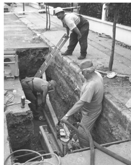
Várpalota, Béke utcai vízvezeték rekonstrukció
