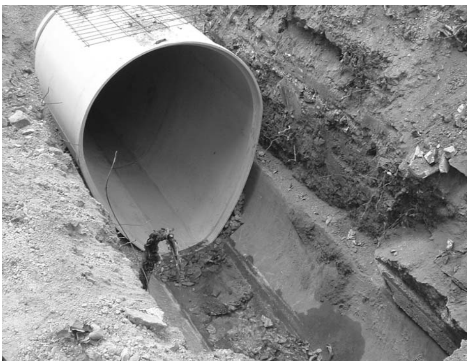
Ilyen és ennél még mélyebb árkok szelték volna át Veszprém belvárosát, ha nem a fúrési technológia mellett döntenek
