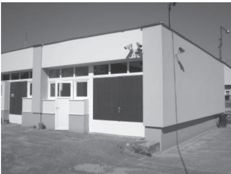
A zirci üzemmérnökség épületét kívül-belül felújították
