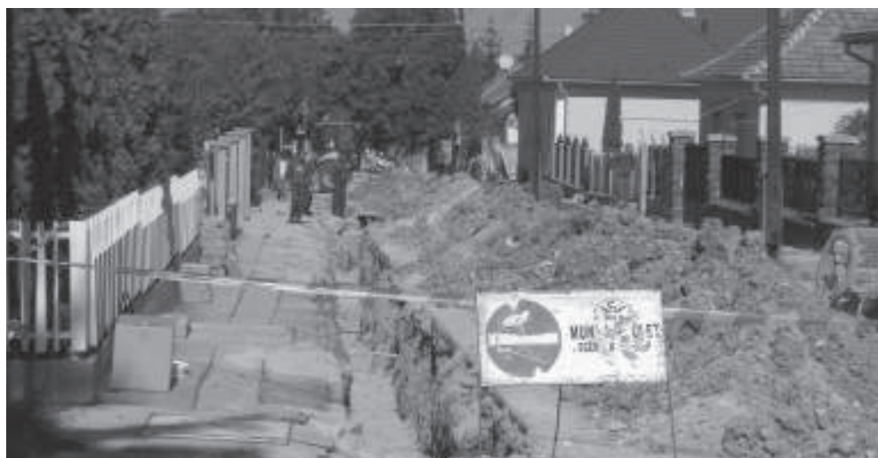
Az ivóvízvezeték rekonstrukció a veszprémi Rózsa utcában
