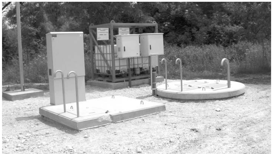
Szagtalanító berendezés is épül a szennyvíz-átemelő mellé
