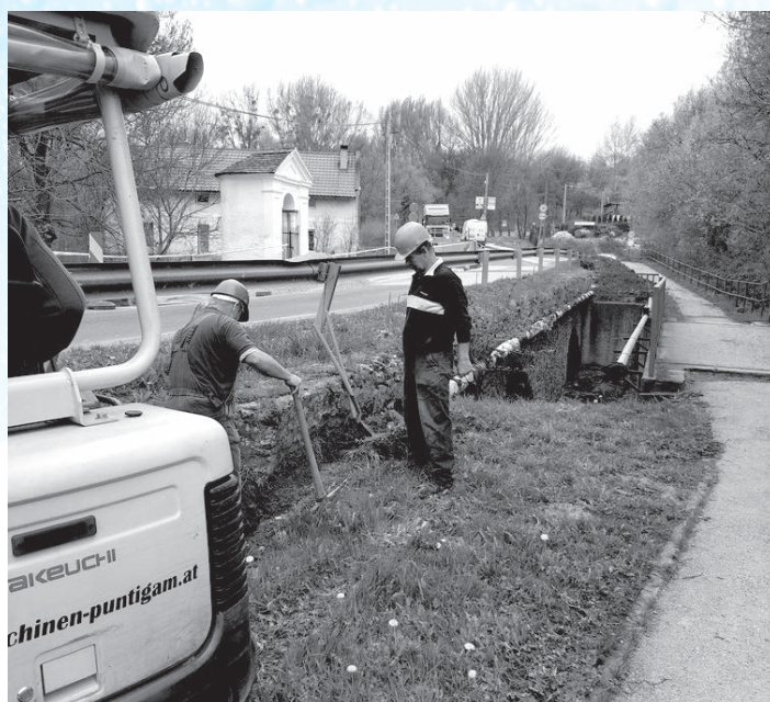
A nagyvázsonyi Szent János - híd oldalára szerelt csőhid rekonstrukciójára is sor került 2018-ban
