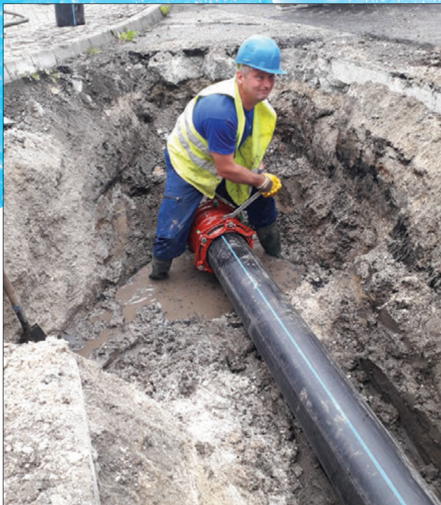
Ivóvízvezeték felújítás Ajkán, nehéz körülmények között
