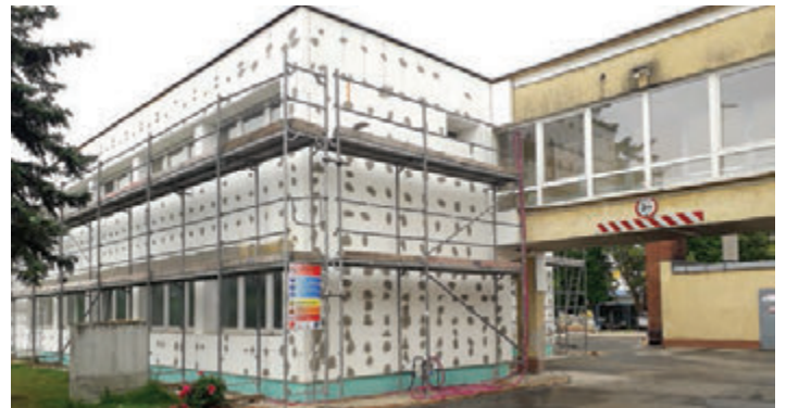
Az Ajkai Üzemmérnökség épület hőszigetelése
